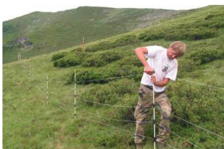
Montage de parc
